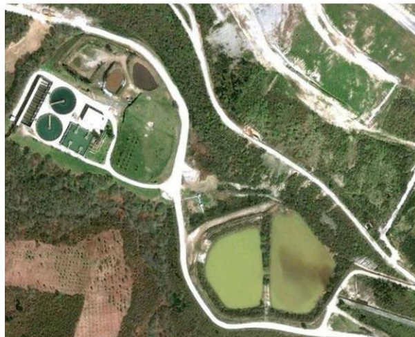
Ilustración 7. Vista de la Depuradora de la Escombrera
