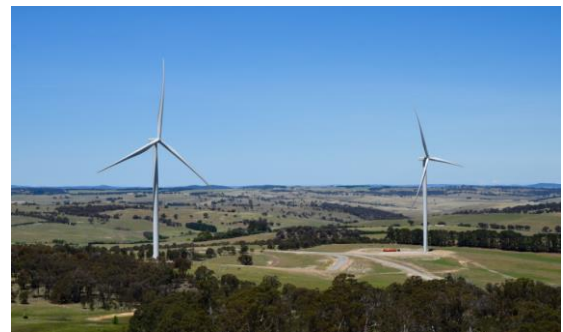
Parque eólico en Australia
