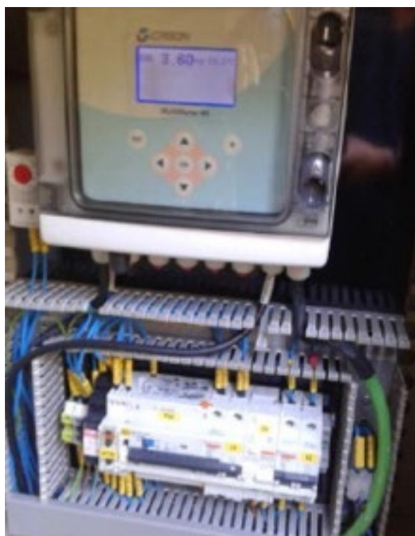
Ilustración 23. Cuadro del oxímetro en la salida de máquinas.
