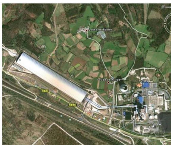
Ilustración 5. Vista de la Central Térmica de Meirama y Parque de Carbones
