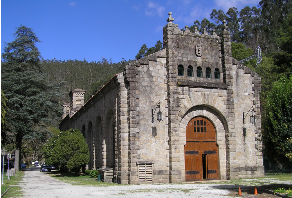
Ilustración 5. Edificio de la Central.
