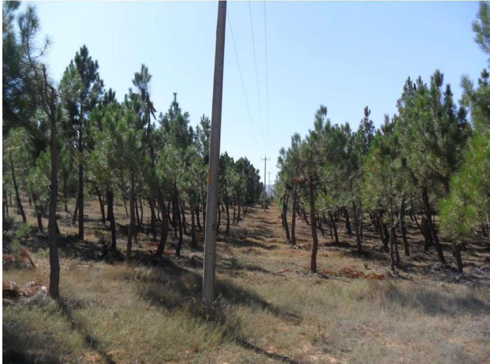
**FOTO 6:** Detalle de la mancha de pinos localizada entre V.8 y V.9. Imagen tomada hacia el punto final. En este tramo la reforma se ha proyectado bajo el eje de la línea existente con objeto de aprovechar la calle de seguridad ya ejecutada por la línea a reformar.
