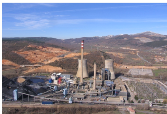
Ilustración 11. Vista general de la Central
