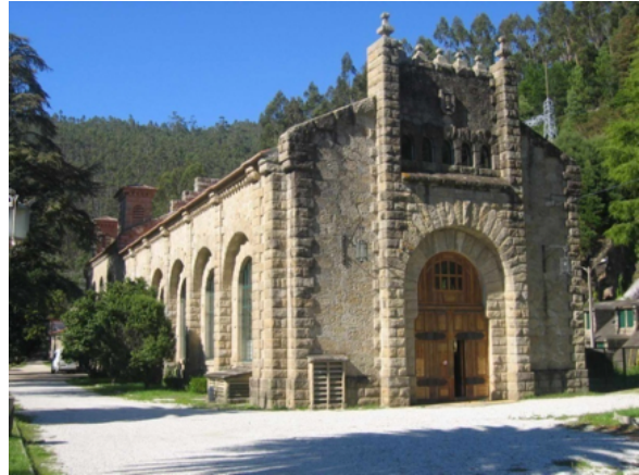
Ilustración 6. Edificio de la Central.
