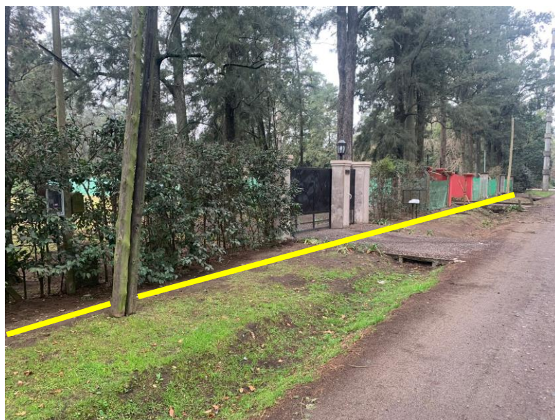
Foto 1. Vista del frente de las viviendas y de las entradas vehiculares, que se ubican sobre la calle Emilio Frers. Se observa vereda de suelo natural donde se emplazará la cañería de gas natural.
