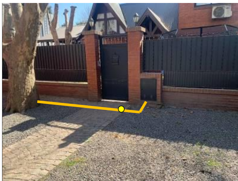
Fotografía 1. Vista del punto de empalme.
