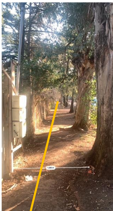
Fotografía 3. Vista de la red que se instalará sobre vereda constituida por suelo natural sin cobertura vegetal, desde donde atraviesa árboles de la especie Casuarina de bajo porte y Eucaliptus de gran porte. Se observa identificada la distancia del árbol a la línea municipal.
