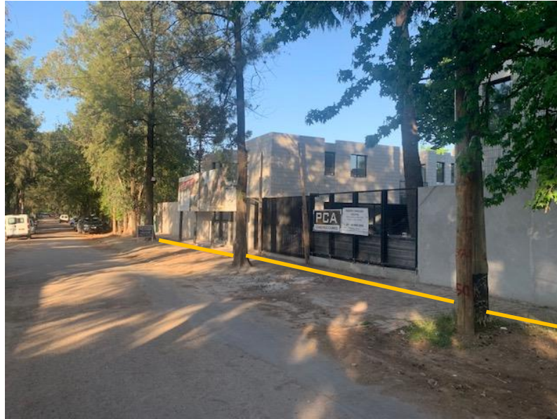
Fotografía 4. Vista de la futura red que se instalará sobre vereda consolidada por baldosas, en acceso a duplex que se encuentran en construcción y en donde se atraviesa en su recorrido dos árboles de la especie Fresno y uno de Casuarina.
