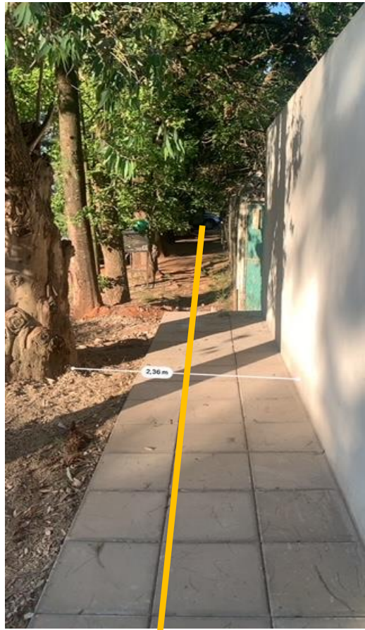
Fotografía 6. Vista de la posible ubicación de la red de gas natural sobre vereda constituída por baldosas. En su recorrido se observa la presencia de árboles dispuestos a una distancia de 2,36 metros de la línea municipal.
