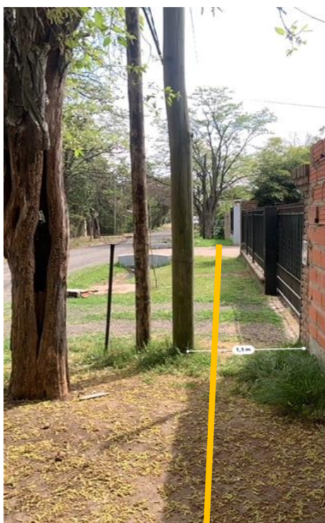
Fotografía 9. Vista del recorrido tentativo de la red de gas natural que se instalará sobre suelo natural con cobertura vegetal. En el recorrido se atraviesa un árbol de la especie Acacia de porte mediano y postes del servicio de video cable. Se encuentra reflejada la distancia de los postes de video cable a la línea municipal.
