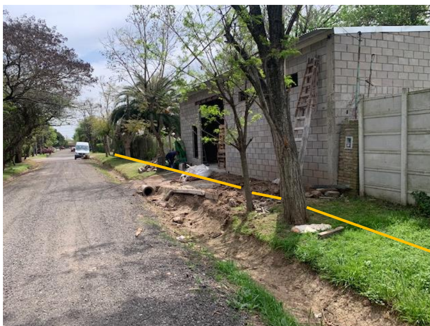
Fotografía 4. Vista de la red que se instalará sobre suelo natural en donde se atraviesan tres árboles, dos de la especie Acacia y uno de Jacarandá.
