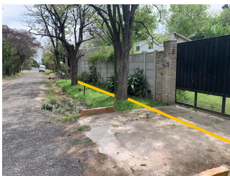
Fotografía 6. Vista de la red que se instalará sobre vereda constituida principalmente por suelo natural, salvo al ingreso de la vivienda que se encuentra con alisado cementicio. Se observan dos árboles de la especie Acacia de mediano porte en su trayectoria.
