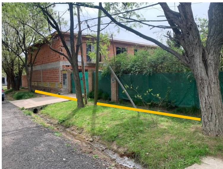
Fotografía 11. Emplazamiento tentativo de la red de gas natural que se desarrollará sobre vereda natural con césped y vista del ingreso a edificación que se encuentra en construcción. En su recorrido se atraviesan 5 árboles de la especie Acacia de mediano porte.
