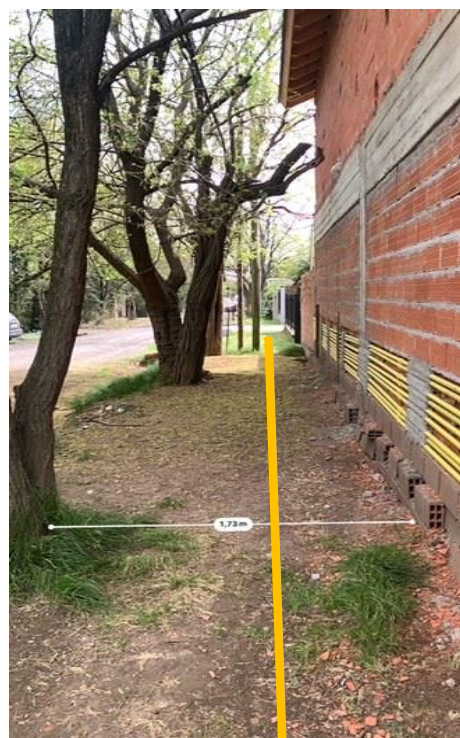
Fotografía 10. Vista de la ubicación tentativa de la cañería de gas natural que se instalará sobre vereda constituida por suelo natural y cobertura vegetal, donde se observan dos árboles de mediano porte de la especie Acacia. Se identifica, además la distancia de 1,73 metros que separa a la línea de árboles existentes con la línea municipal.
