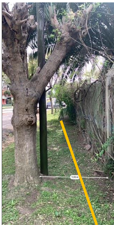
Fotografía 3. Vista de la red que se instalará sobre suelo natural, en cercanía de un árbol de la especie Fresno. Se observa identificada la distancia del árbol a la línea municipal.
